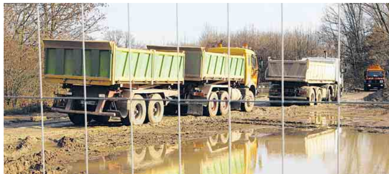
Die Baulaster stehen schon Schlange, um den Aushub für den Durchstich des Niddaaltarms abzutransportieren.
